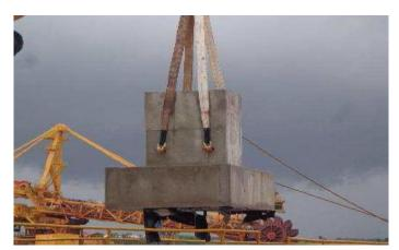
**Situação antes da Boa Prática:** Içamento era realizado com cinta de segurança, a qual não proporcionava estabilidade da carga e os trabalhadores ficavam próximos à carga para guia-la e empreender esforço físico.
